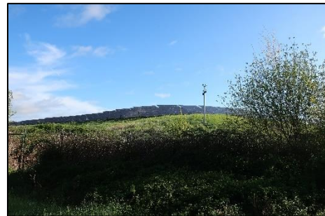
Parc photovoltaïque existant à la Genetière Source : Artifex, 2019
