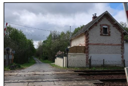
Habitation du « Patureau de la maison » Source : Artifex 2019
