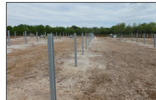
Exemple de pieux battus Source : URBASOLAR
