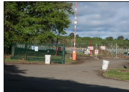
Parc photovoltaïque en construction Source : Artifex, 2019
