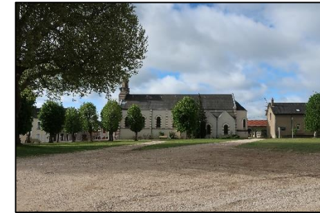
Centre de Gièvres Source : Artifex, 2019
