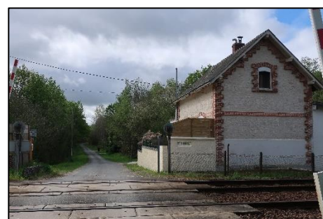
Voie ferrée au Nord du site d'étude
