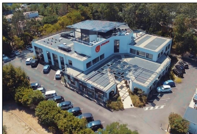
Siège d'Urbasolar à Montpellier (34) Source : URBASOLAR
