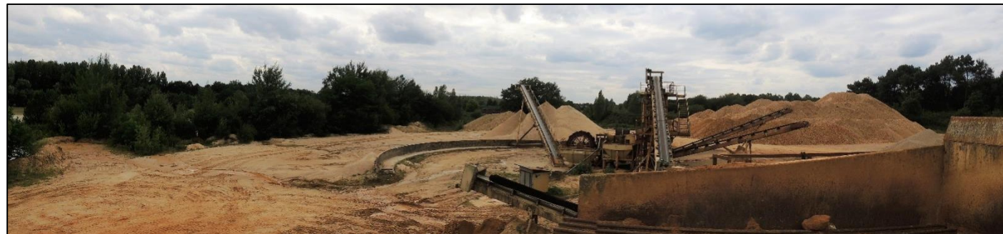
Installations de traitement des matériaux de la Carrière LANDRE sur la partie exploitée Source : Artifex 2019
