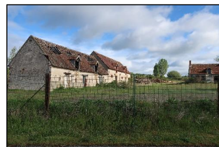
Ruines de « la Morandière » Source : Artifex 2019
